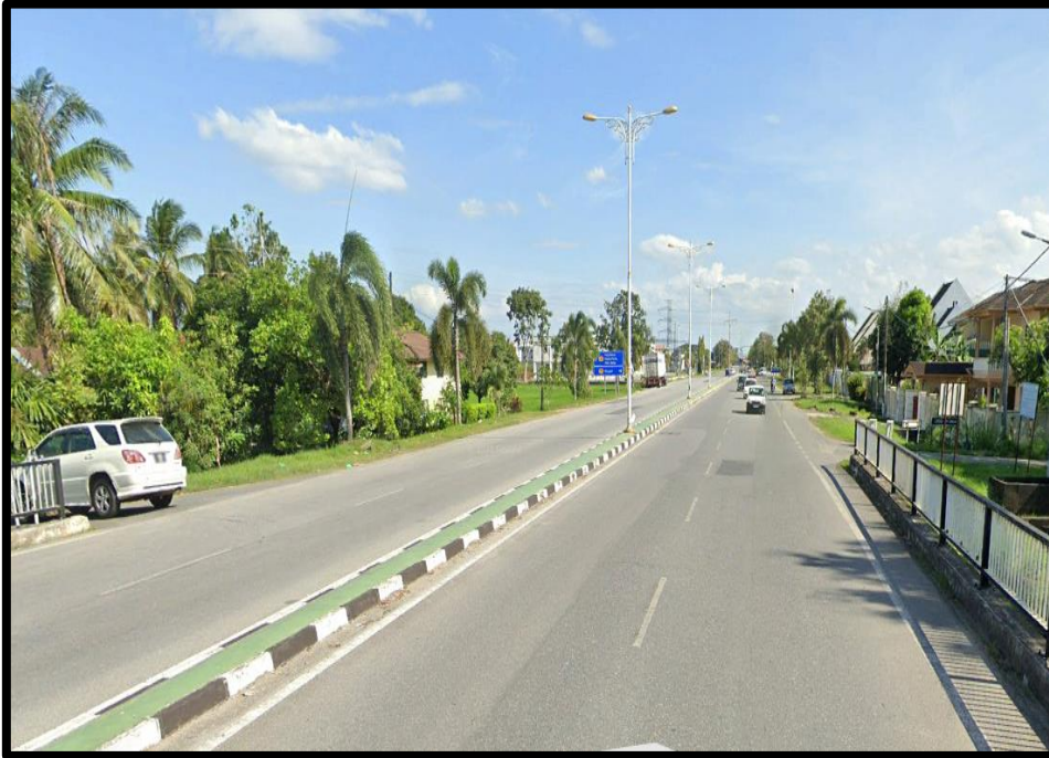
JALAN PADANG BEHOR
