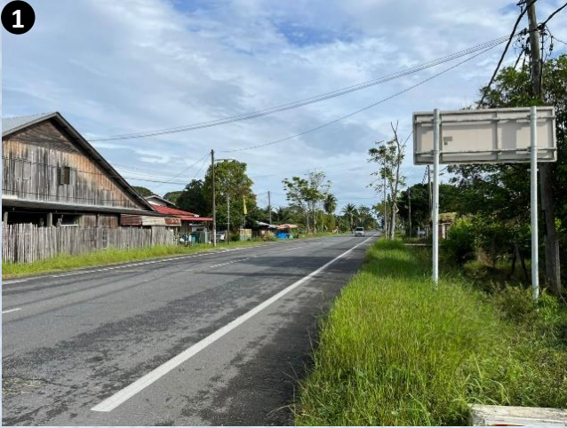
1 Jalan Kaki Bukit (FT 7) di hadapan tapak cadangan pemajuan (menghadap ke ke arah Beseri). Jalan ini adalah akses utama ke tapak tersebut.
