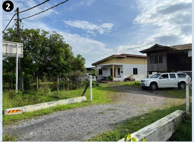
2 Rumah kampung sedia ada di atas Lot 436 yang terlibat dengan pengambilan tanah untuk jalan masuk ke cadangan pemajuan.
