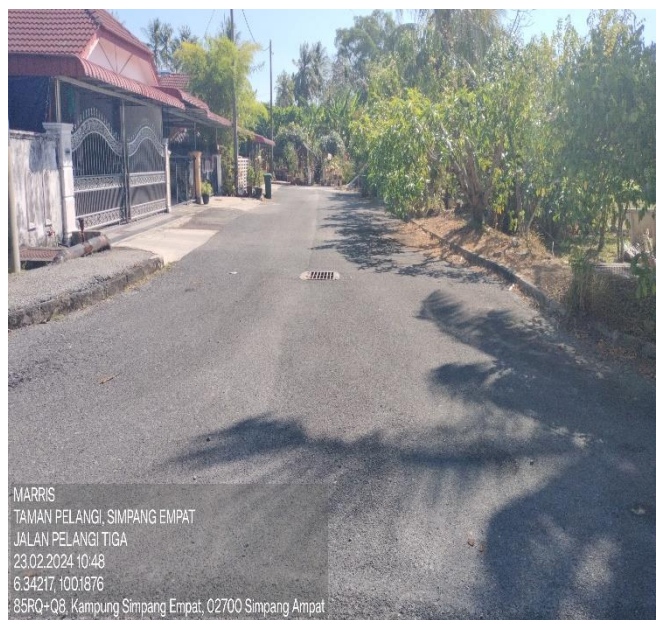
JALAN PELANGI TIGA
